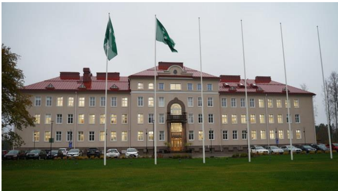
1930 öppnades "nya sidan" i det som nu är huvudbyggnaden på Ekåsenområdet. I dag finns Raseborgs stads administration i huset. Bild: Christoffer Westerlund / Yle
